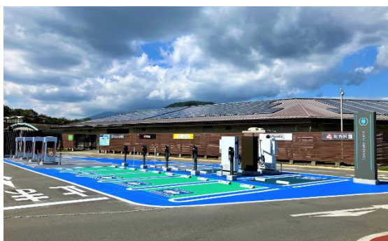
増設した充電エリア
